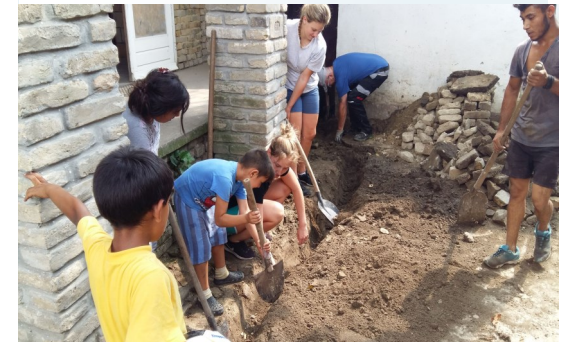
(Rohrverlegung Suppenküche Cantavir)
